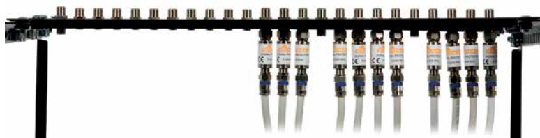
Zabezpieczenie przeciwprzepięciowe R48602 zainstalowane na patchpanelu R9120312 po wymianie przejścia F/F na dłuższe E80380
